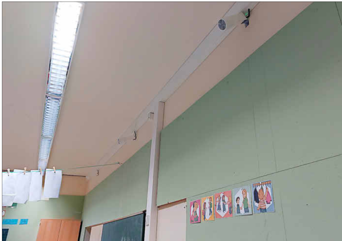
Oben rechts sind die Ionengeneratoren unauffällig an der Decke des Klassenraumes angebracht.
