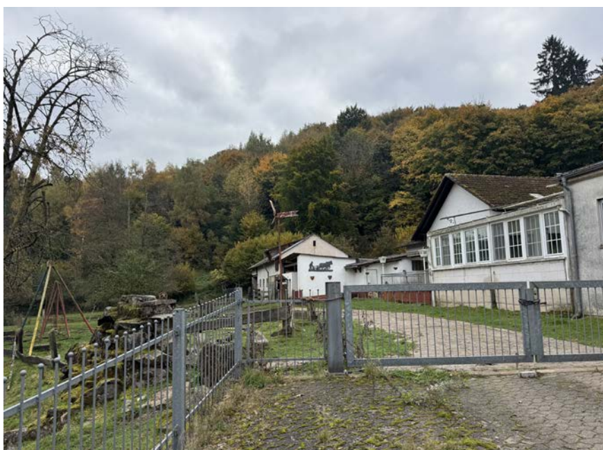
Blick auf rückwärtigen Anbauten des historischen Mühlengebäudes
