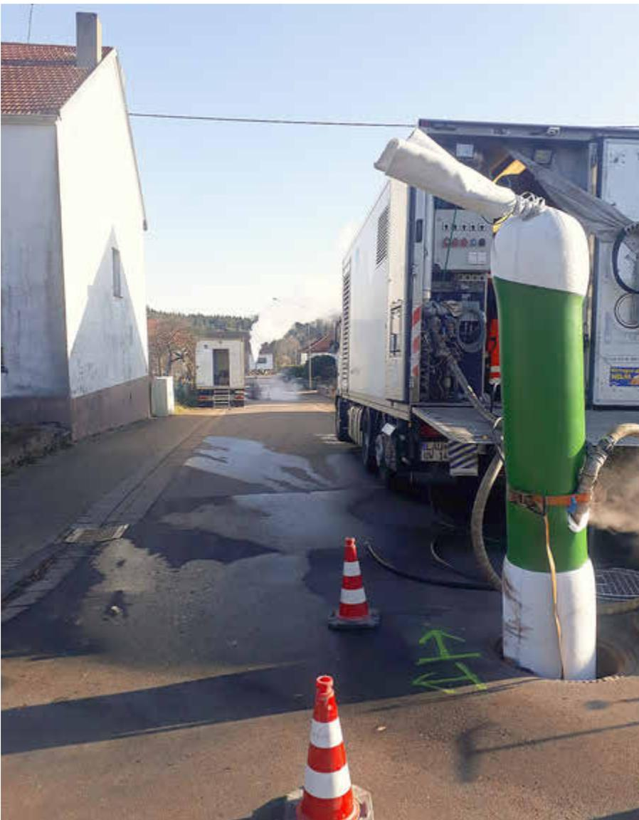
Bei dem hier durchgeführten sogenannten Schlauchlining-Verfahren wurden die beschädigten Kanalrohre von innen saniert, d. h. es wurden kunstharzgetränkte Gewebeschläuche in die schadhafte Kanäle eingezogen und anschließend mittels Wasserdampf oder UV-Licht ausgehärtet.
