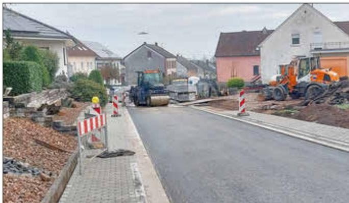
Am Mittwoch den 04.12.2024 wurde im 3. Bauabschnitt die Tragschicht asphaltiert. Es sind noch einige Verbundsteinarbeiten
