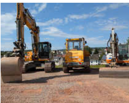
Bereit für ihren Einsatz auf der Baustelle
