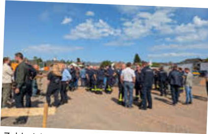
Zahlreiche Gäste erschienen zum Spatenstich der neuen Feuerwache
