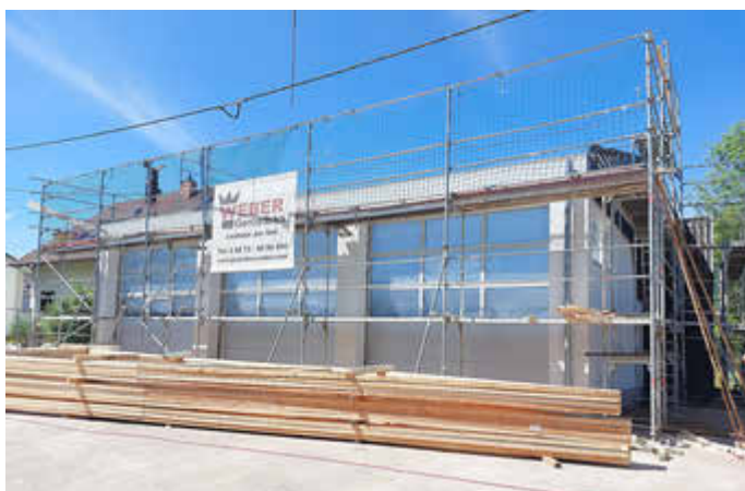
Fundament, Dach und einige Innenräume vom Feuerwehrhaus in Wahlen werden saniert
