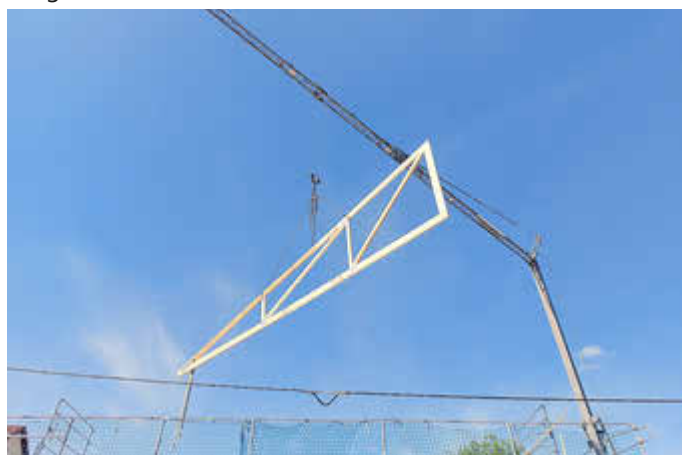
Es geht hoch hinaus – die neue Konstruktion für das Dach des Feuerwehrhauses Fotos: Gemeinde
