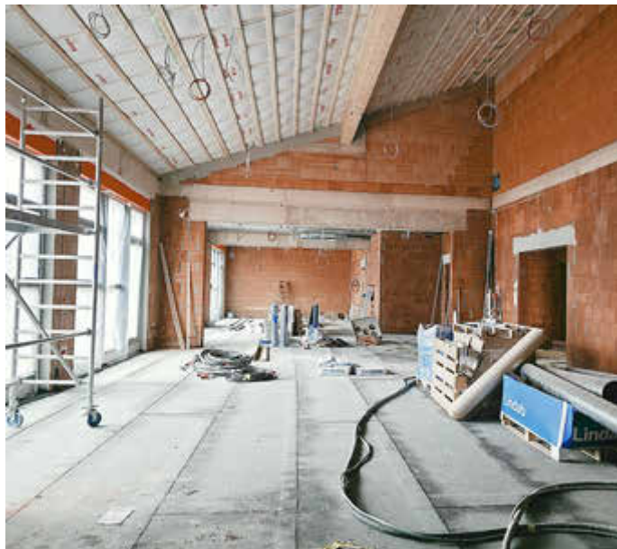
Hier entsteht die neue Mensa
